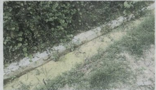
此发生水灾。沟渠堆满泥漿, 居民担心会因
