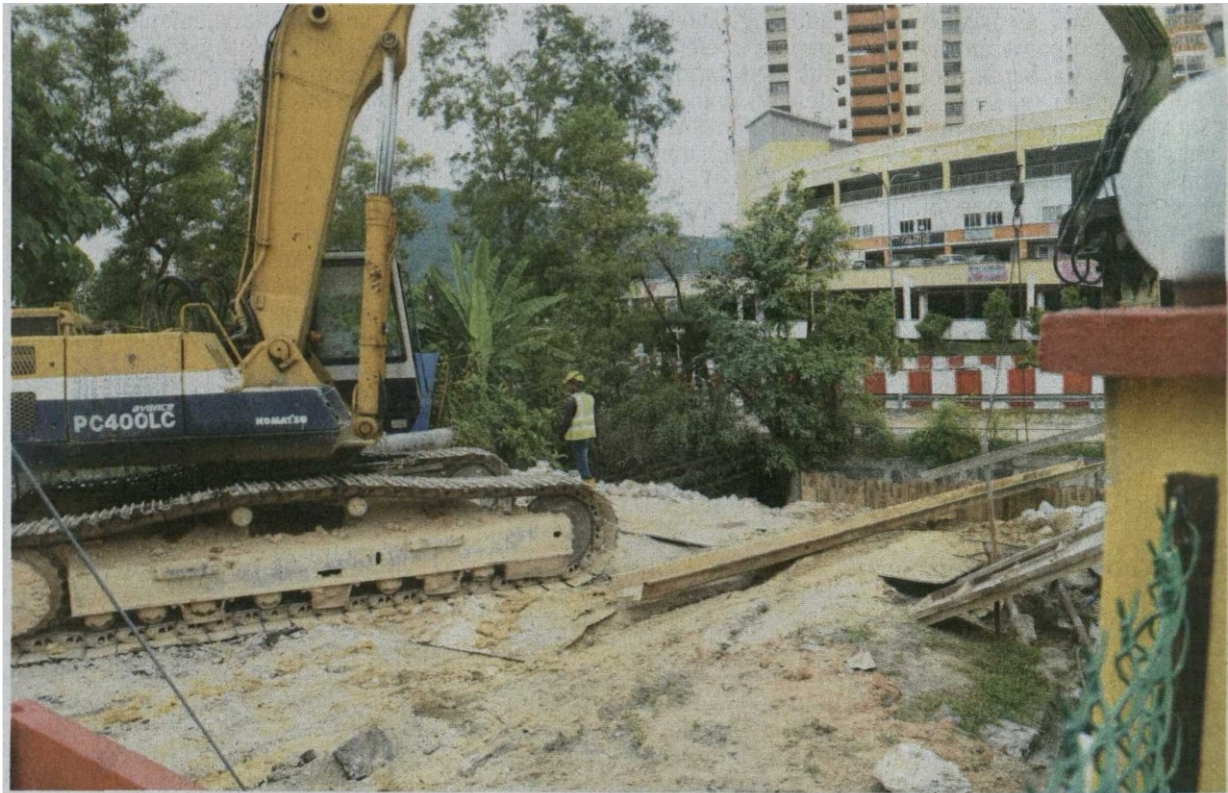
KONTRAKTOR terlibat giat melakukan pemasangan cerucuk bagi mengukuhkan tebing dan mengatasi masalah pergerakan tanah. - UTUSAN/NADIA NURSYAMIMI MOHD. NOOR
